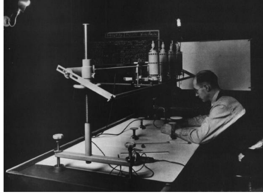
Şekil 7. Topografik harita hazırlamak için mltipleks ekipman kullanan bir Arařtırma topografı, 1936.
